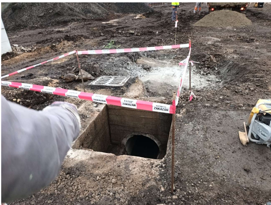
Bourání betonu u UV v Přemyslově ulici
