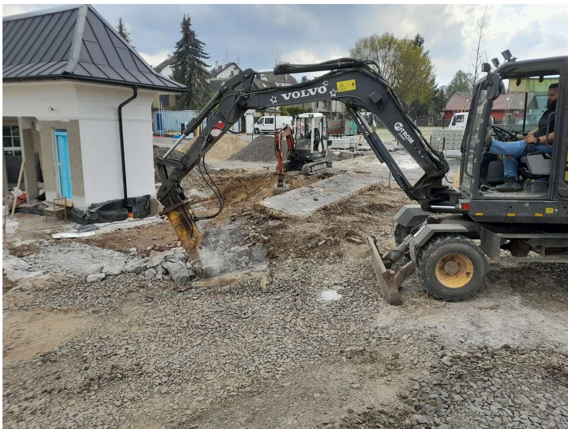
Bourání betonu u SO 05a
