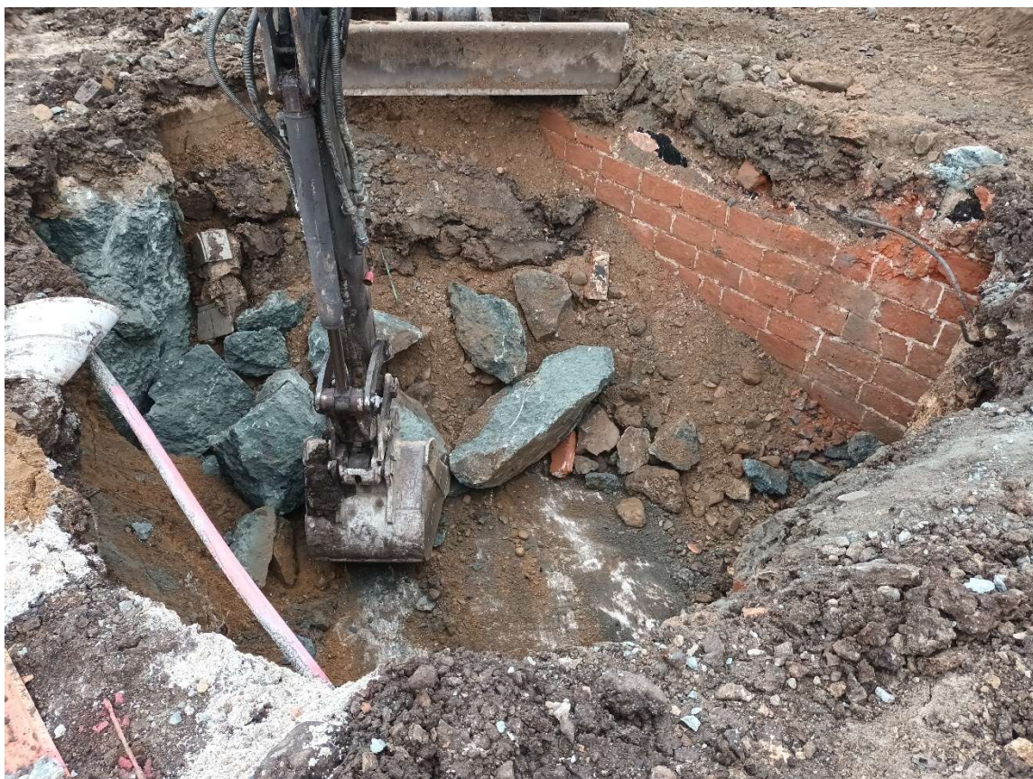
Bourání betonu a základů z cihel u VŠ 1
