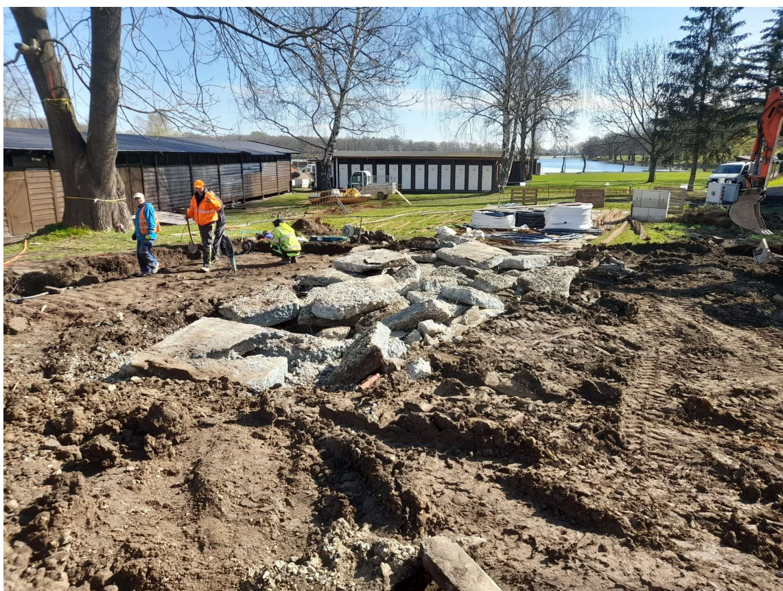
Bourání betonu propojka pod infocentrem
