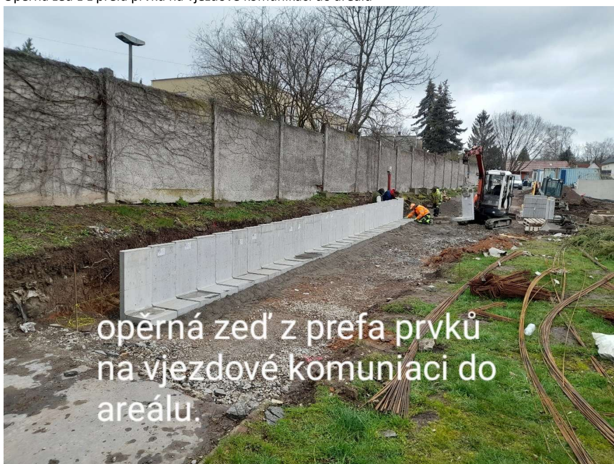
Opěrná zeď z L prefa prvků na vjezdové komunikaci do areálu
